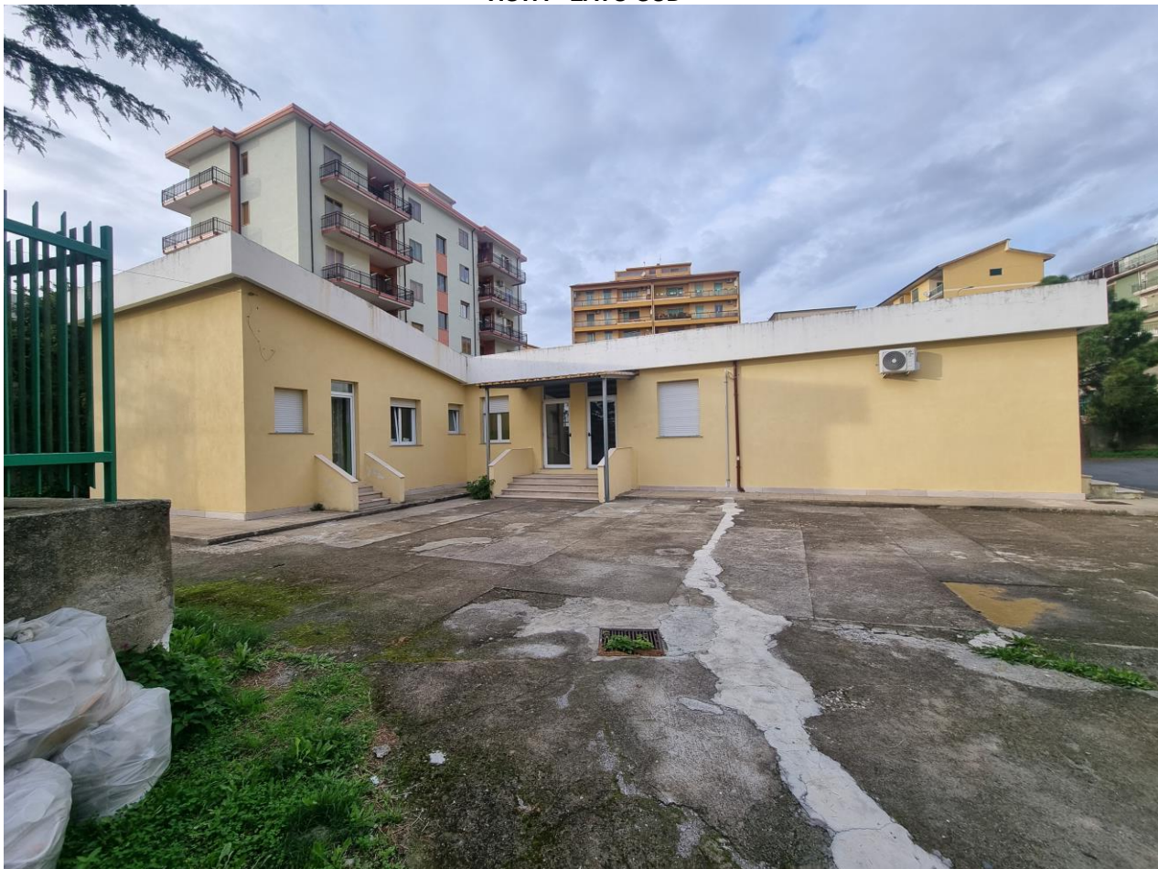
VISTA LATO SUD
